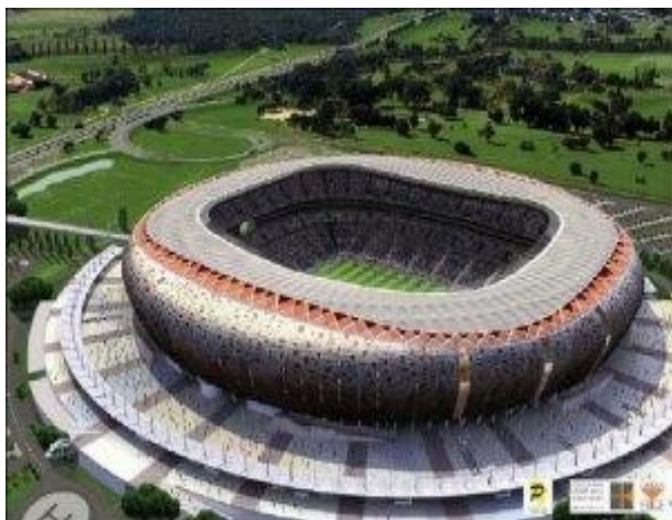
ESTADIO SOCCER CITY, UBICADO EN LA CIUDAD DE JOHANNESBURGO.
